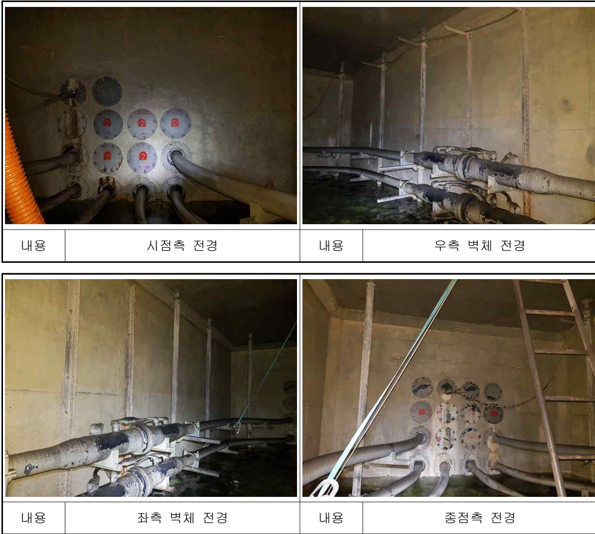
【사진 8.1】 일산~호수 #16 전경
