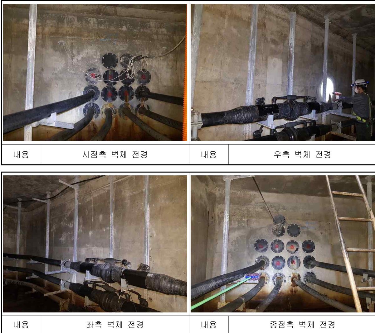
【사진 8.5】 일산~호수 #17 전경
