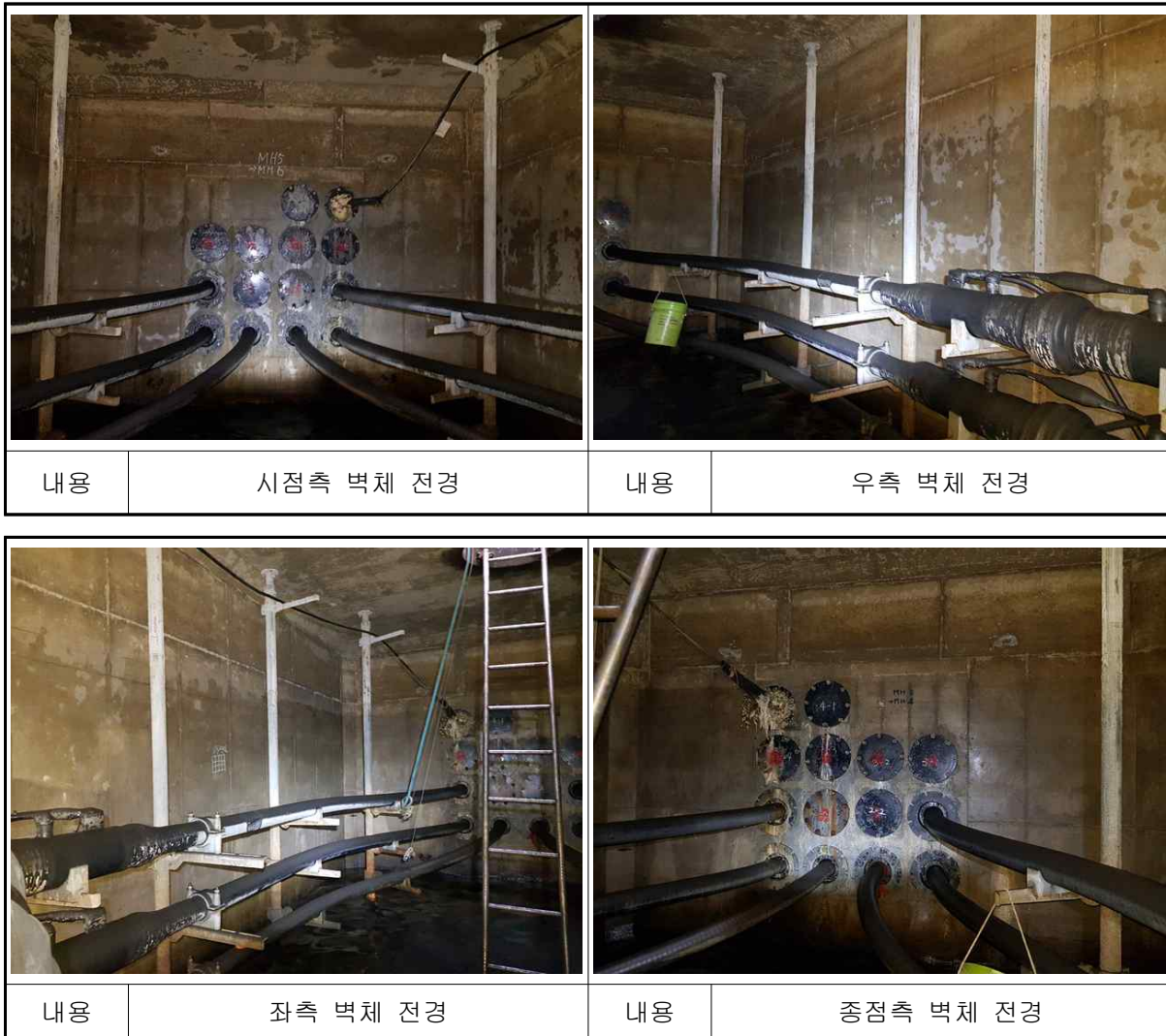
【사진 8.13】 일산~호수#19 전경
