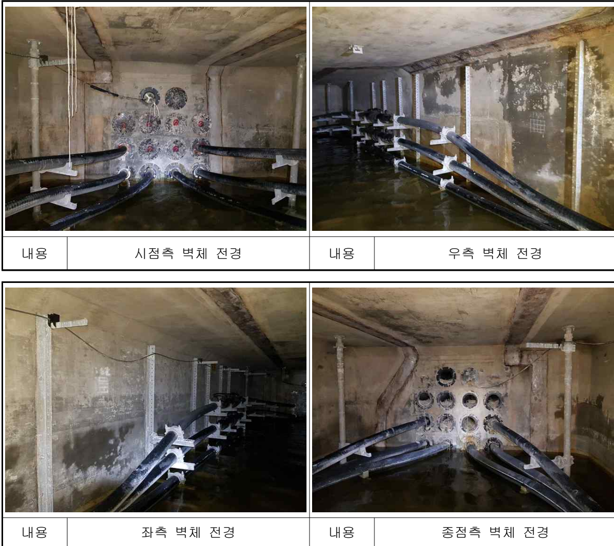
【사진 8.29】 일산~호수#23 전경
