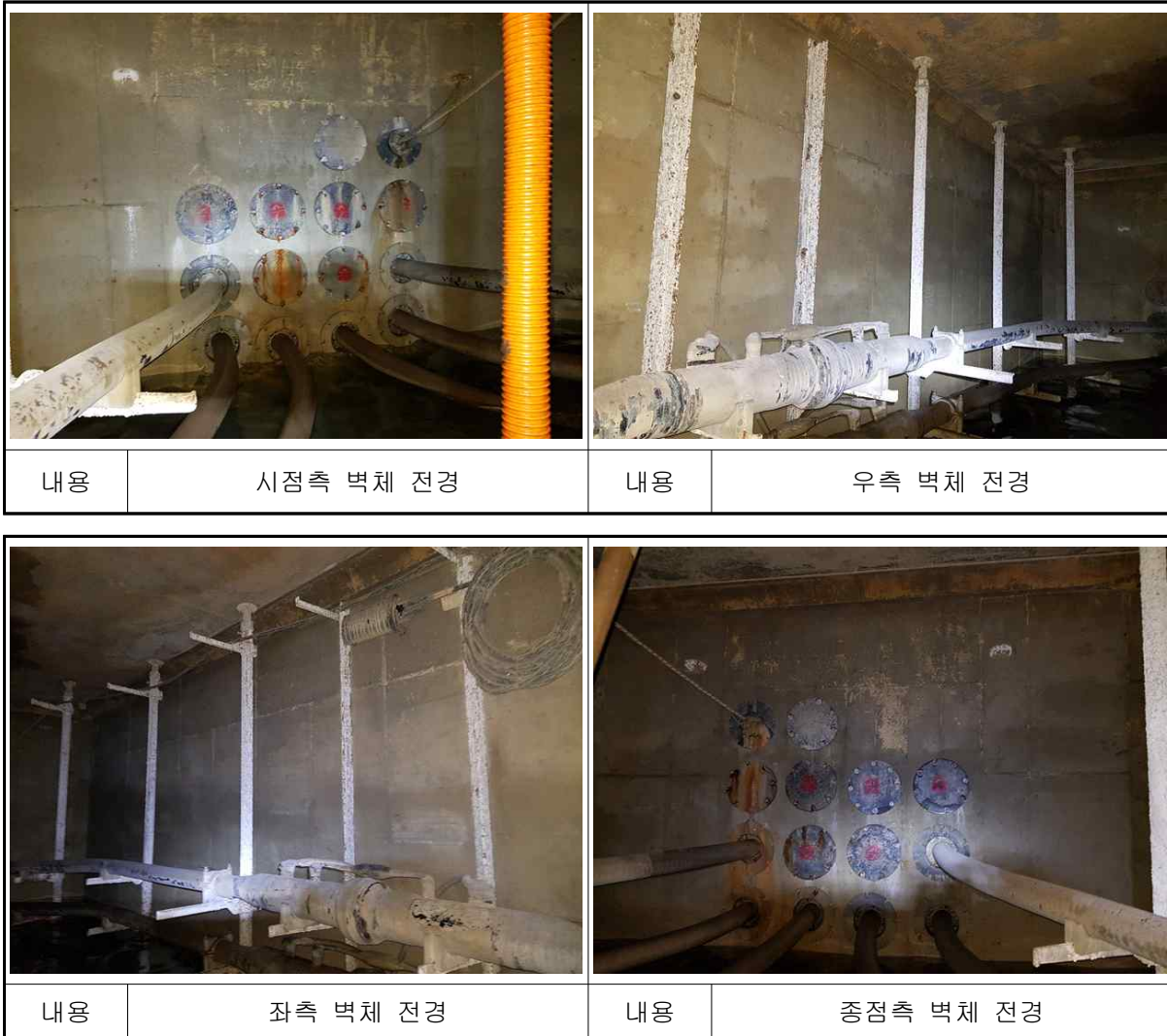
【사진 8.17】 일산~호수#20 전경
