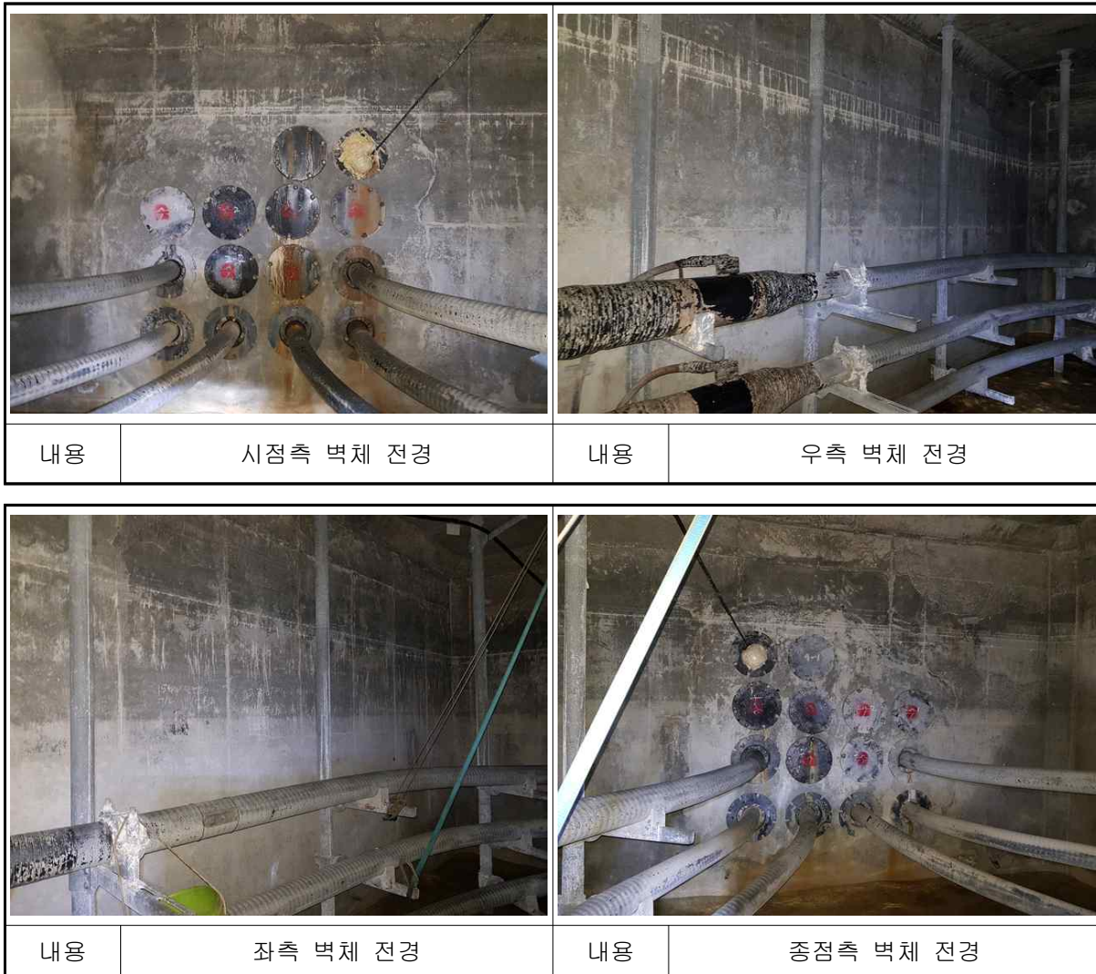
【사진 8.9】 일산~호수#18 전경
